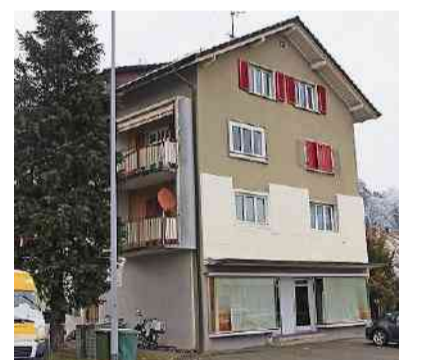
An der Fassade klebt Styropor. CM
